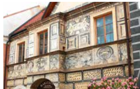
Mödling, Rathausgasse, Bürgerhaus mit Fassadenmalerei, 2. Hälfte 16. Jh. © Karl Gruber (wikimedia)
