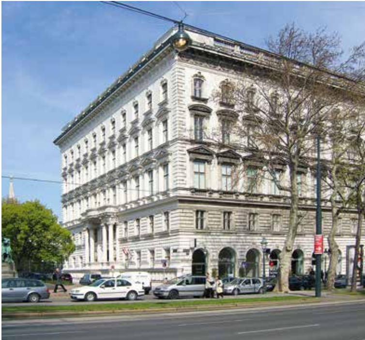
Wien, Ehem. Palais Schey von Koromla, Johann Romano und August Schwendenwein, 1862–1864
