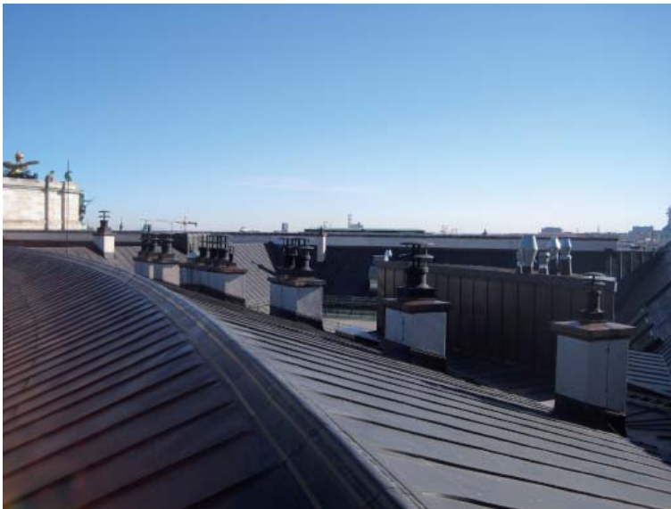
Abb. B.70: Originale Kaminaufsätze auf dem Dach des Segmentbogens der Neuen Burg
