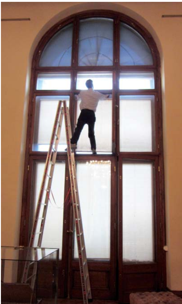
Abb. D.3: Die äußere Fensterkasten-Entlüftungsklappe der großen Rundbogenfenster in Saal IX und XIV muss von der darunterliegenden Ebene geöffnet bzw. geschlossen werden.
