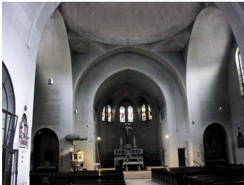
Abb. A.24: Staubverschmelungen als untrügliches Zeichen für Kapillarkondensation an kalten Bauteilen als Folge konvektiver Heizsysteme (Pfarrkirche Ottakring, 1160 Wien)
