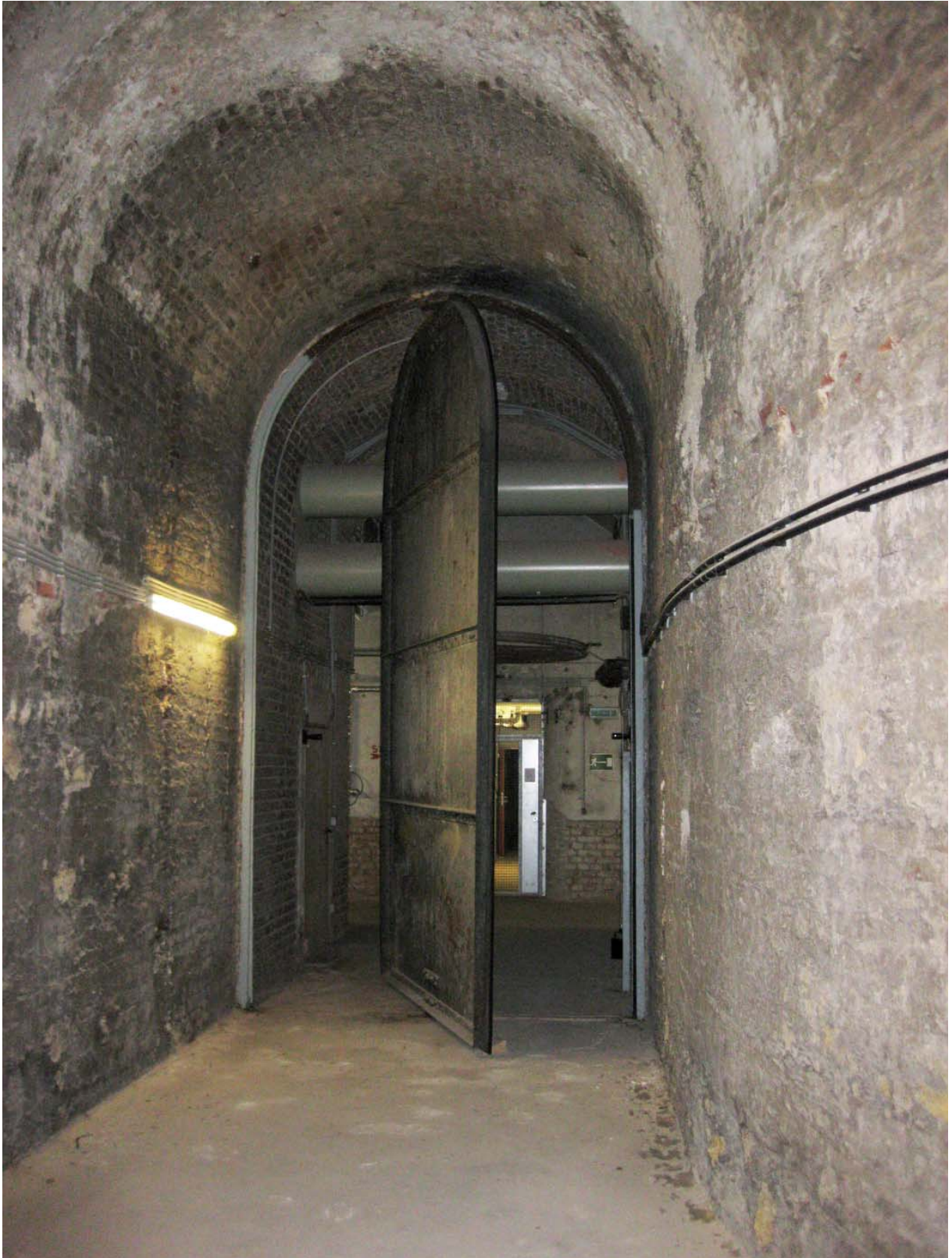
Abb. B.16: Drehtür im Eingang zum 2. Keller des Corps de Logis der Neuen Burg. Die Seilzüge zum Öffnen und Schließen wurden 2009 rekonstruiert.
