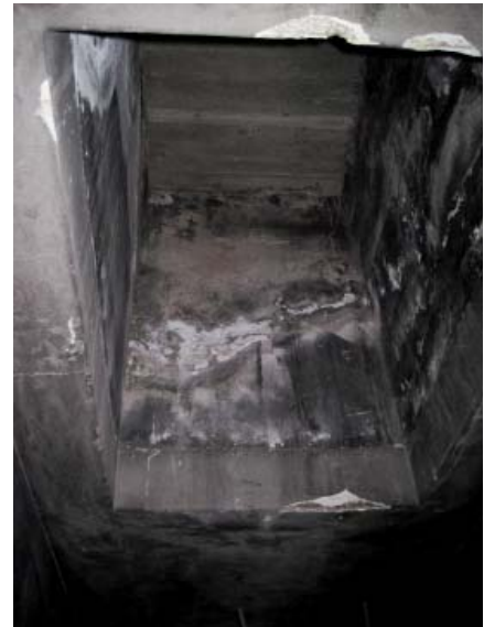
Abb. B.74: Zugemauerte vertikale Verbindungsöffnung vom Hauptkollektor im Segmentbogen im westlichen Teil des Mittelbaus
