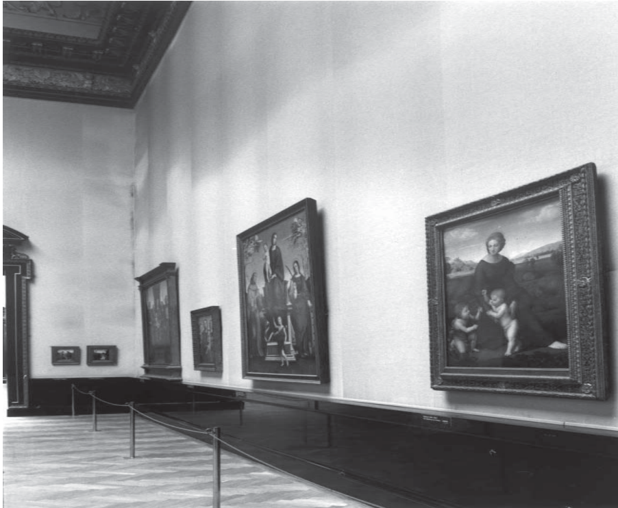
Abb. A.25: Verstaubung und Schimmelbildung in den Außenwandecken von Saal IV der Gemäldegalerie des KHM (vor 1990)
