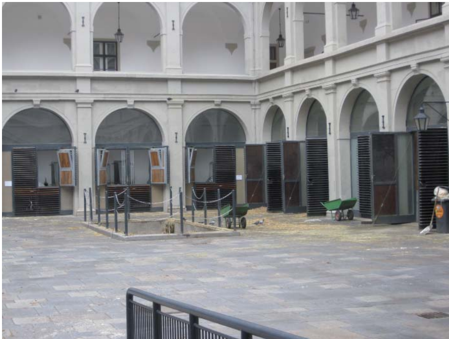
Abb. B.2: Außenbeschattung für die Lipizzaner in der Stallburg
