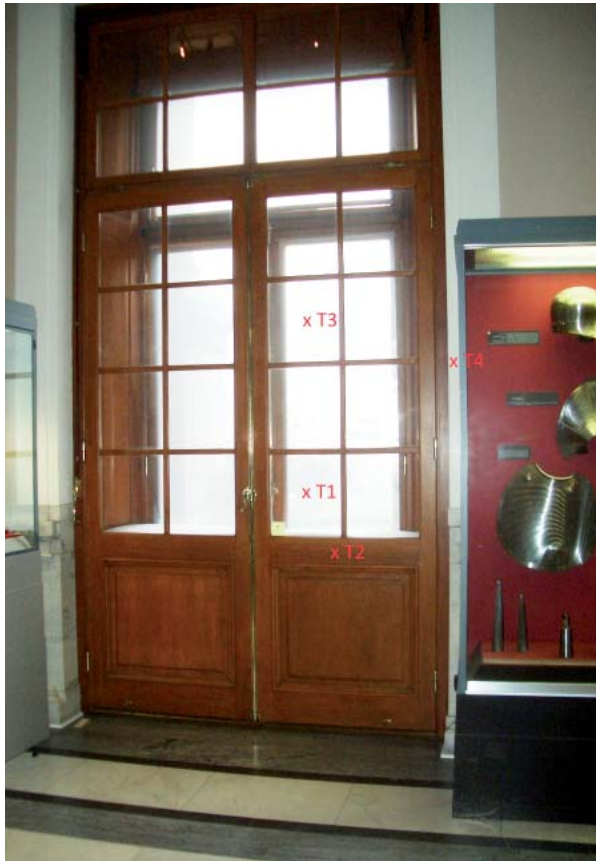
Abb. C.20: Optimierte Tür auf Plateau 1 der Neuen Burg (Dichten der Außenflügel und „Fensterpölster“ im Zwischenraum); markiert sind die Messpunkte T1 - T4 der Thermofühler auf Fenstergläsern, Türrahmen und Laibung
