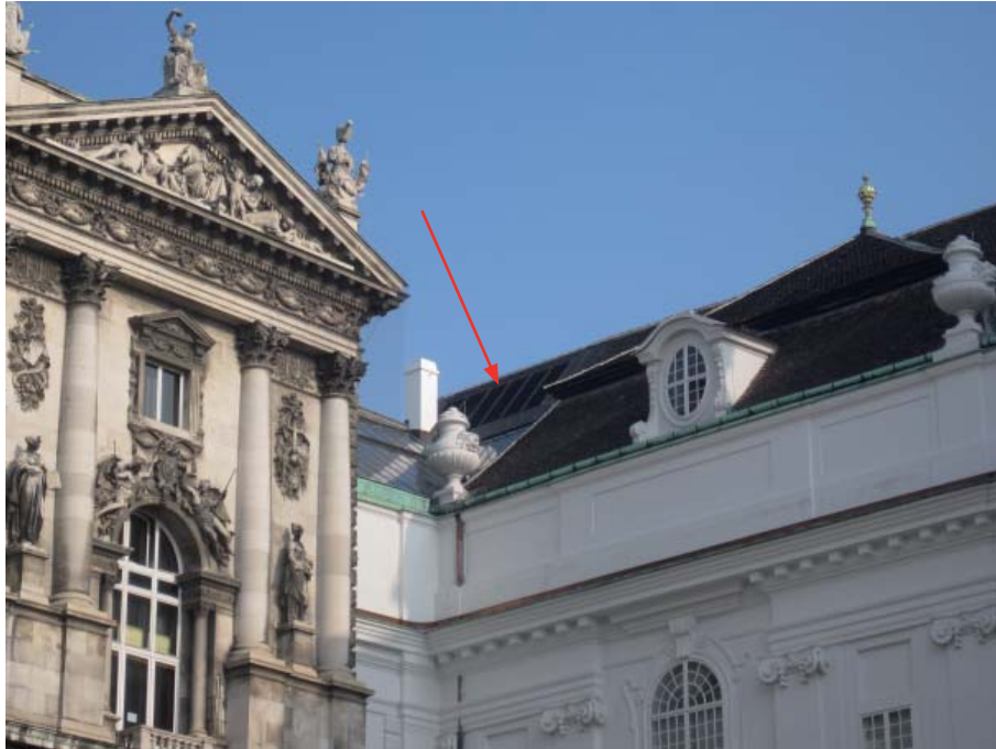
Abb. B.11: Ansaugöffnung für Klimaanlage des Konferenzentrums im Dach des Prunksaales der Bibliothek (Hofburg, Bibliothekshof)
