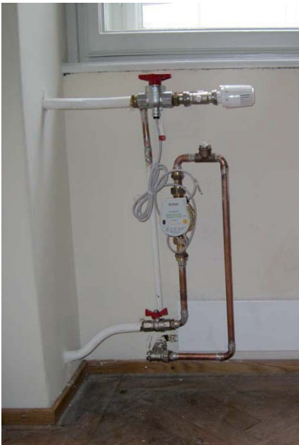
Abb. C.26: Anstelle der Radiatoren wurde in der oberen Werkstatt die Sockelheizleiste entlang der Außenwand verlegt. Die Sockelheizleiste ist an die vorhandene Vorlauf- und Rücklaufleitung des Wärmeverteilsystems angeschlossen. Der Wärmeverbrauch kann über einen Wärmemengenzähler abgelesen werden.
