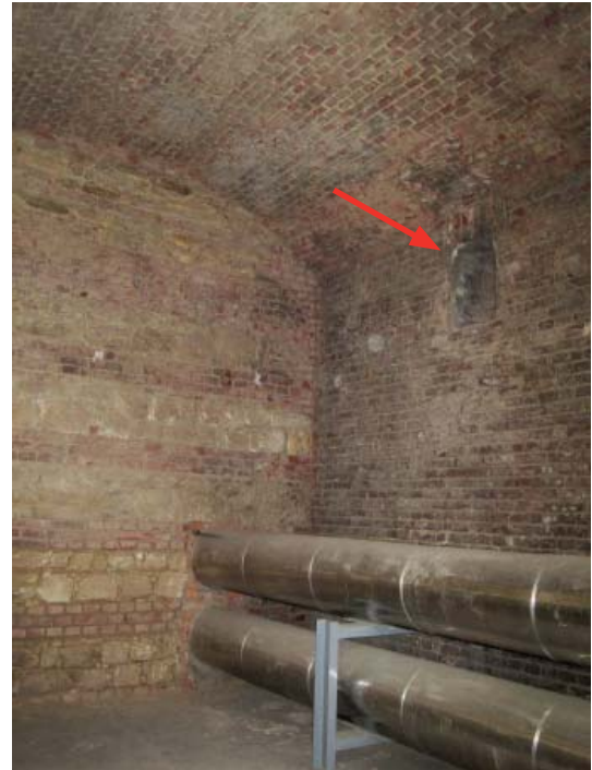
Abb. B.18: Zwei der zahlreichen abgemauerten Schächte (links) und teilweise geöffneter Schacht (rechts) im 2. Keller im Quadrant C. Die Außenmauer zeigt die typische Streifentextur der Gründerzeitbauten, in deren Fundamenten die Reste der geschleiften Stadtmauer verarbeitet wurden.
