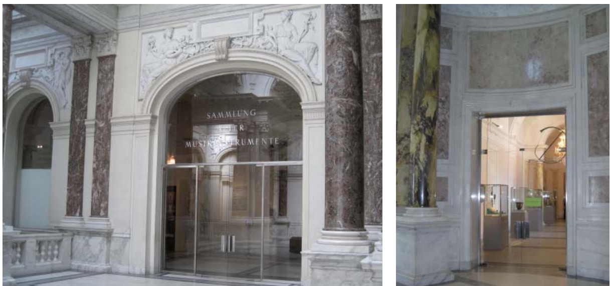
Abb. B.85: Klimaabschnittstüren in den Zugangsbereichen der SAM; links Pufferzone Vorraum Marmorsaal, rechts Eingang zur rechten Seitengalerie.
