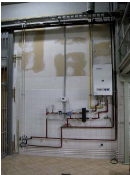
Abb. C.24: Das Klavierdepot der SAM wurde nachträglich mit einer auf die Betonaußenwände applizierten Bauteiltemperierung ausgestattet.
