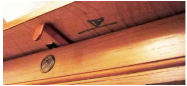
Abb. D.2: Die Schuber unter den Fensterbrettern müssen während der Heizperiode verschlossen sein
