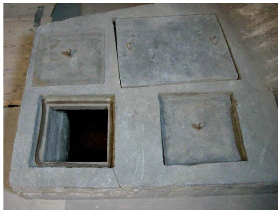
Abb. A.13: Ehemalige Abluftöffnungen in den Dachraum im Städtischen Museum Braunschweig (Dr. A. Walz, HAUM Braunschweig)
