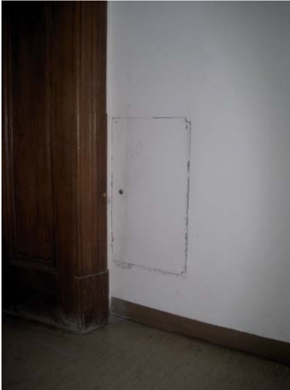
Abb. B.64: Die originale Revisionstüre von Schacht Nr. 17 war vom Türstock verbaut (links). Durch Trennen des Stocks und Einbau von Scharnieren konnte die Tür zugänglich gemacht werden (Mitte, rechts).
