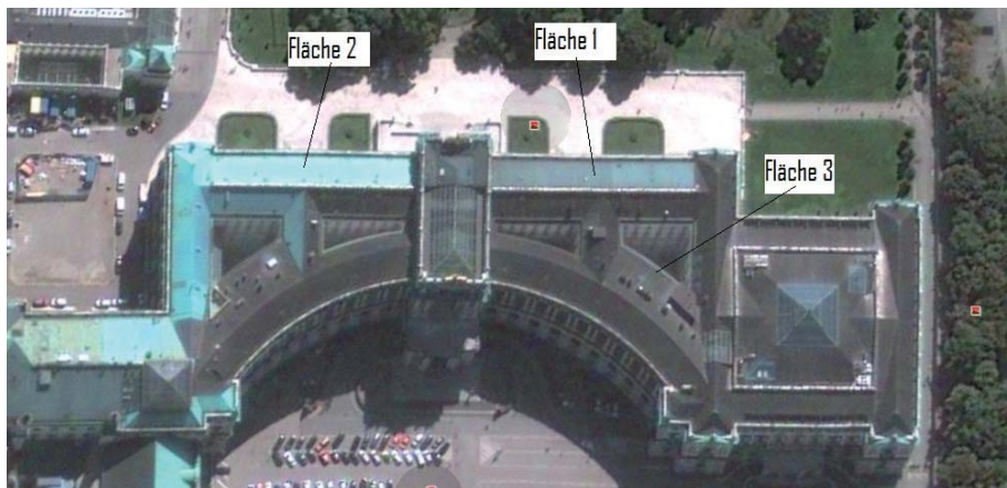
Abb. C.48: Für Photovoltaik-Nutzung geeignete Dachflächen der Neuen Burg
