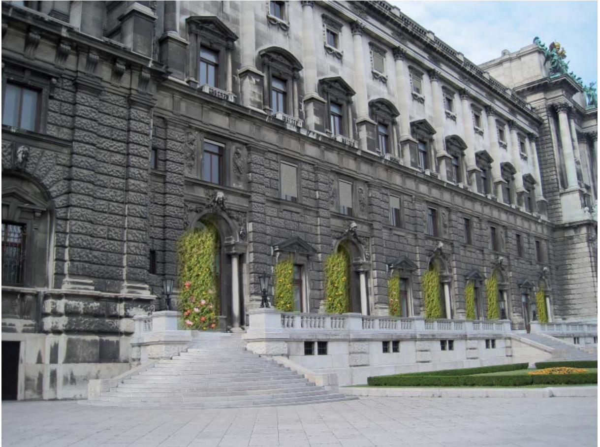
Abb. C.44: Fotomontage der Südfassade der Neuen Burg mit Pflanzenschirmen vor den Fenstern und Türen im Hochparterre und Außenbeschattung im Mezzanin und 2. Obergeschoß. (Fotomontage: Stefanie Huber)
