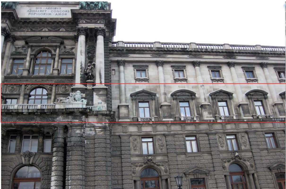
Abb. C.39: Südostfassade der Neuen Burg: Alle Fenster des 1. Stocks sind mit einer fixen Außenbeschattung ausgestattet.
