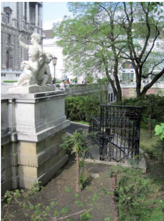
Abb. B.14: Lufteinlass in den Luftbrunnen. Links: südöstlicher Lufteinlass im Burggarten; rechts: Lufteinlass von innen
