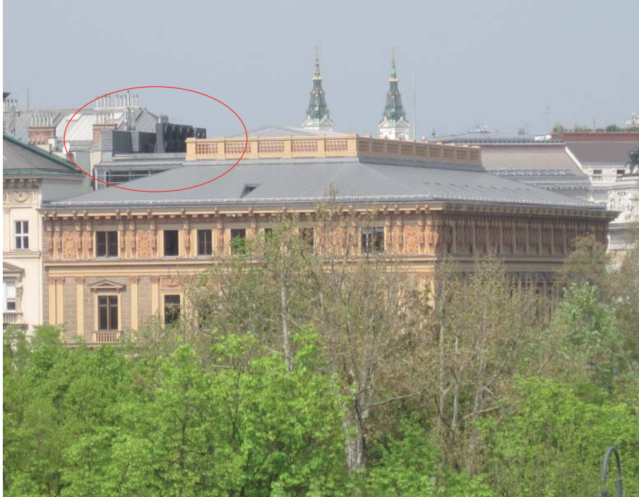
Abb. B.8: Palais Epstein mit Klimaanlage auf dem Dach
