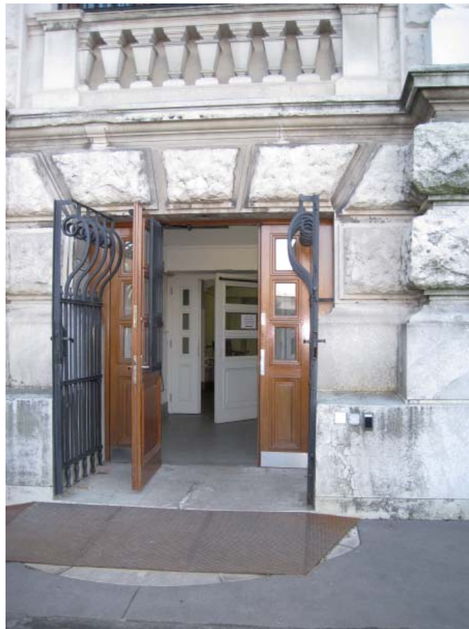
Abb. B.83: Eingang zur D-Stiege; durch die Türautomatik sind beide Türen des Windfangs offen.
