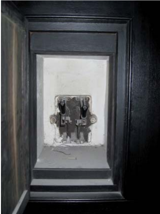
Abb. B.37: Originale Steuerelemente und Seilzüge für Jalousienklappen; in die Türstockverkleidung eingebaute Schalthebel (links); im Schacht dahinter (rechts)
