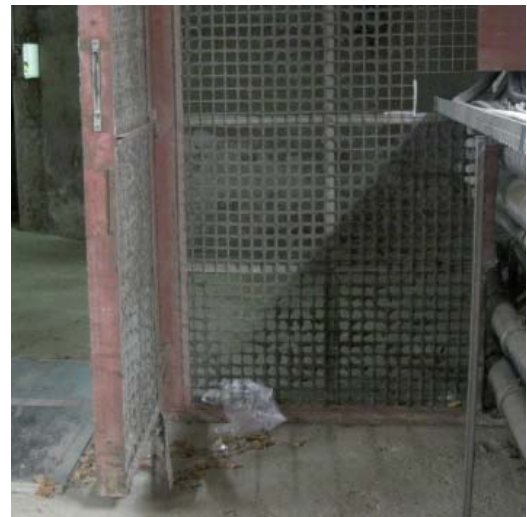
Abb. B.77: Durch Staubflusen verschmutztes Gitter im Einlassbereich des Hauptstollens bei der Gittertür
