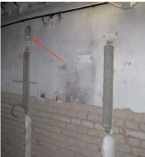
Abb. B.21: Ehemalige Klappensteuerung mit Seilzügen außerhalb der Luftheizkammer
