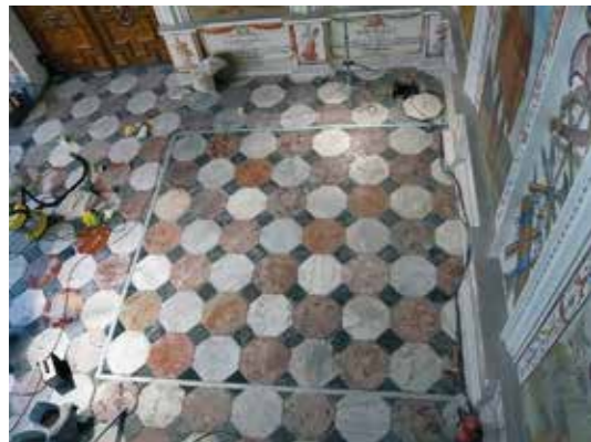
Nachsorgearbeiten Steinboden Spanischer Saal
