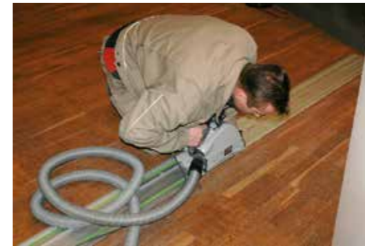
Abdichten des Bodens mit Spritzkork
